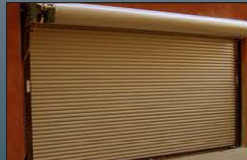
Overhead Door - Rolling Steel/Curtain
